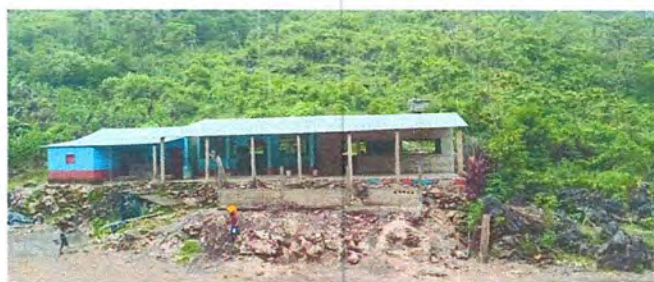
Foto 4: Colocación de ventanas del nuevo edificio
