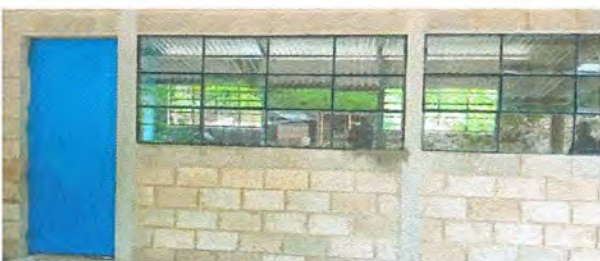
Foto 5: Finalización de colocación de ventanas
