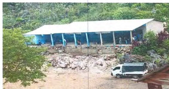
Foto 2: Culminación del entechado del nuevo edificio
