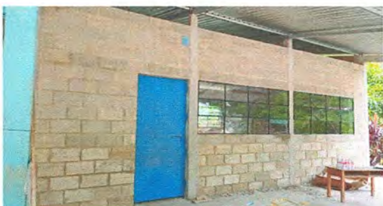
Foto 3: finalización de colocación de puertas
