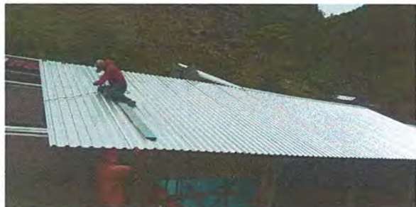
Foto1: Colocación de entechado de nuevo edificio
